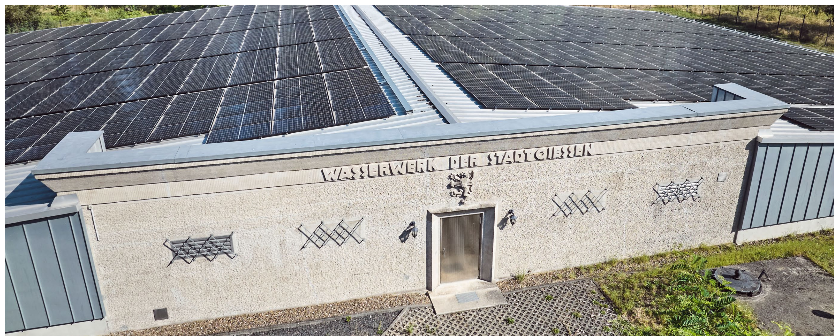
Bild: Großflächen-PV-Anlage auf dem Hochbehälter der SWG
